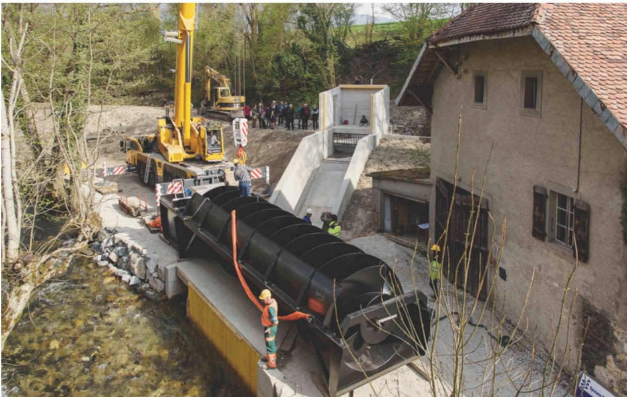
La vis hydrodynamique juste avant qu'elle ne rejoigne son socle de béton: 18 tonnes posées en douceur. CÉDRIC SANDOZ
